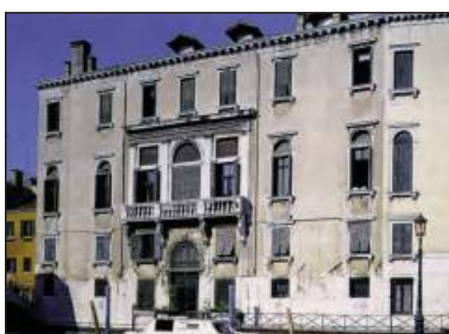
La facciata del Palazzo rinascimentale che ospita le collezioni, sul rio e campo San Vio
